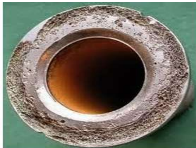
Gambar 2.4 Korosi celah pada sambungan pipa (Deky; 2014)
