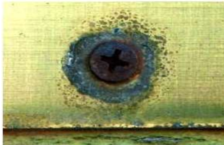
Gambar 2.2 Korosi galvanic pada sambungan baut (Deky; 2014)
