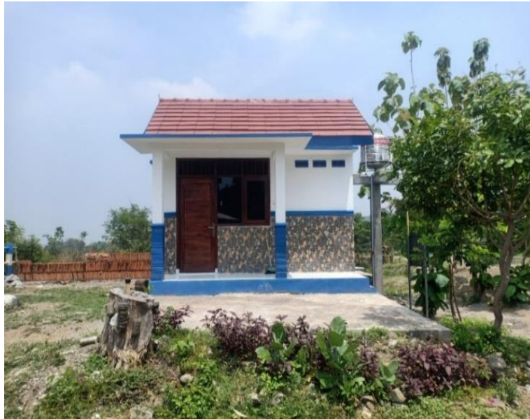
Gambar 4.3. Control House Bendung DI Padi Pomahan (Sumber: Dokumentasi Pribadi)
