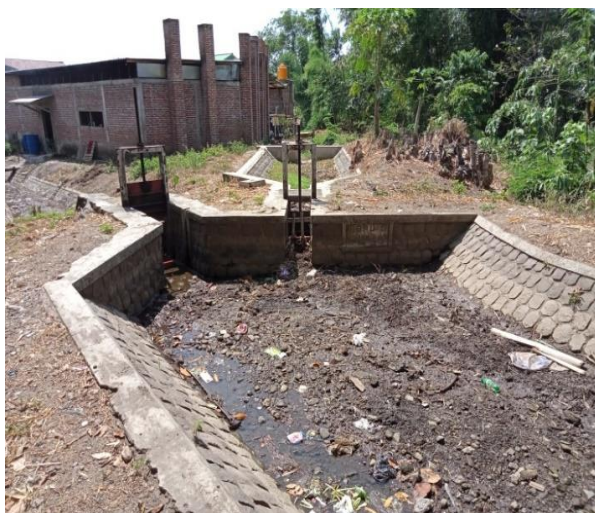
Gambar 4.11 Kondisi Saluran Pugeran (BPU 3) Sumber: Dokumentasi Pribadi
