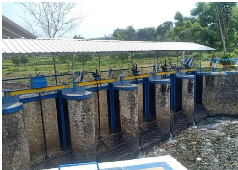
Gambar 4.4. Bangunan Sekunder Daerah Irigasi Padi pomahan (Sumber: Dokumentasi Pribadi)
